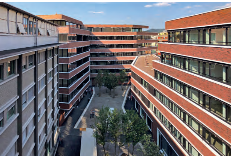
Wohnüberbauung Brünighof , Luzern Architektur: Höing & Voney mit PEBA Architekten, Luzern
