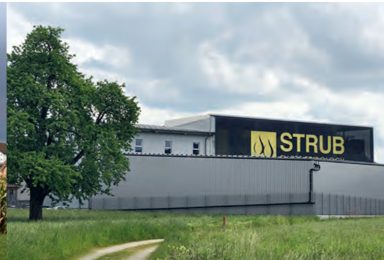
Tanklager Strub & Co. AG , Reiden Architektur: PDN Architekten Planer GmbH, Zofingen
