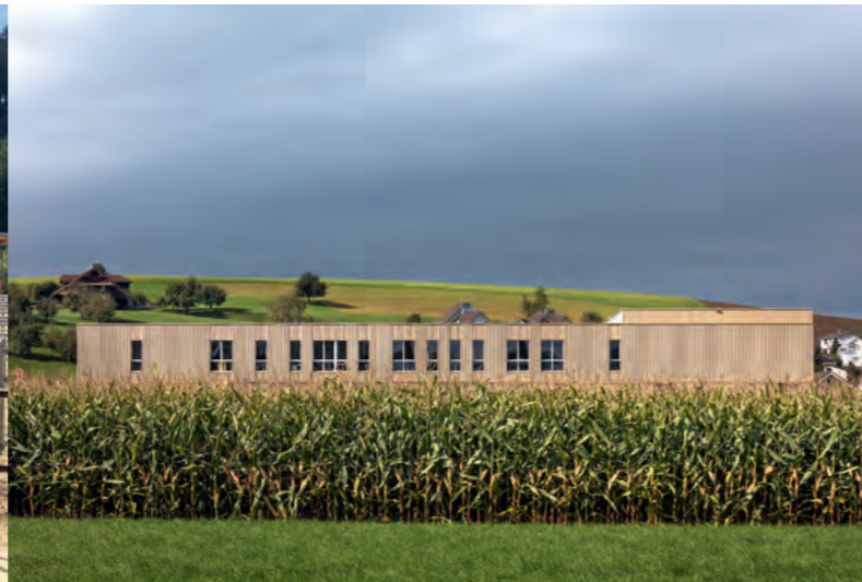
Industriehalle Hobimag , Schötz Architektur: Masswerk Architekten AG, Luzern
