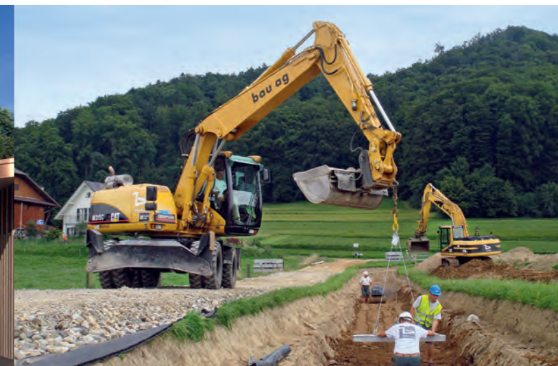
Erdgasleitung West , Reiden Ingenieure: B + S AG, Bern
