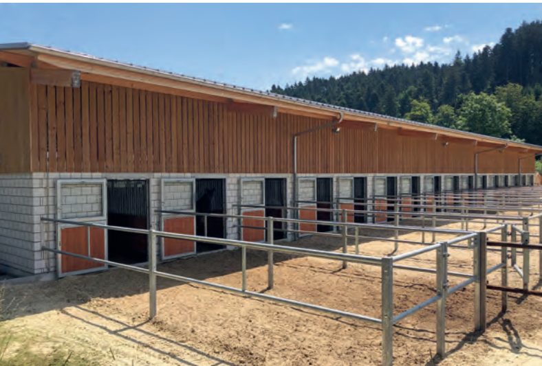
Pferdestall Blumer , Richenthal Architektur: Zaugg AG, Rohrbach
